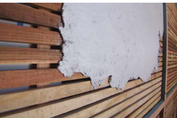
木摺りに砂漆喰を塗り下地を施工したもの。漆喰は薄塗仕上で使用されるだけでなく、性能が高い事から下地から施工もします
