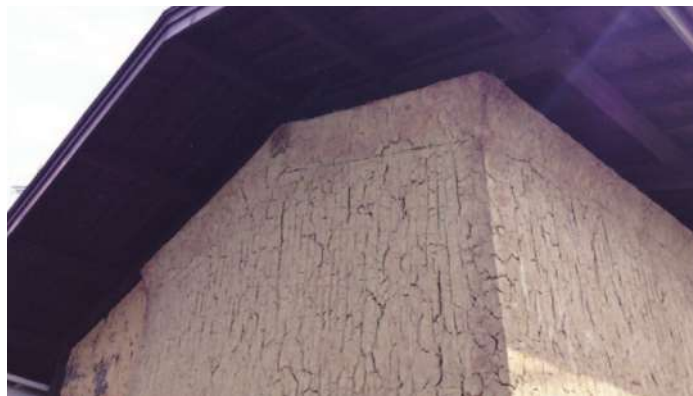
築200年の土蔵。未改修の状態ですがしっかりと現存しています。土自体の性能は変わっていない事と木部の損傷も少ない事から、この上から土を塗れば、当時の状態で再生が可能です
