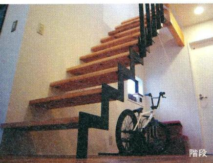
杉の段板に鉄のササラと手すりを組み合わせた階段。
